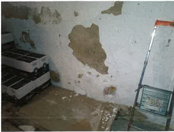
7. kép: vizesedés miatti vakolatleválás a falon
